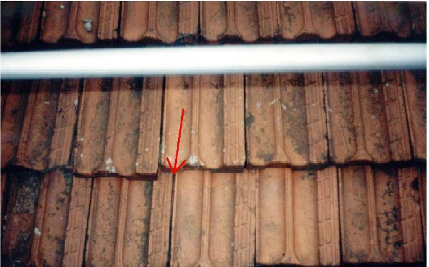
As telhas estão mal encaixadas. Então, a água da chuva vai cair bem no meio do vão entre uma telha e outra.
