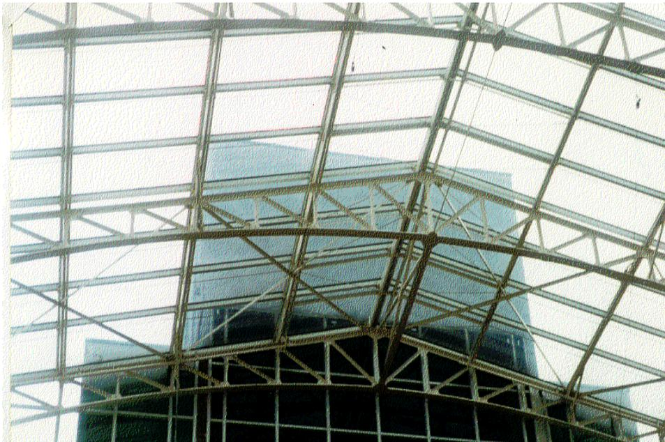
Contraventamentos do plano do telhado de estrutura treliçada, de telhado em duas águas, sistema de contraventamento longitudinal ( mãos francesas e tesouras verticais longitudinais).
