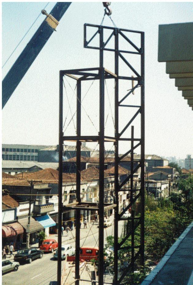
Contraventamento de pórtico em cabos de aço extremamente finos, quase imperceptíveis sob a pele de vidro.
