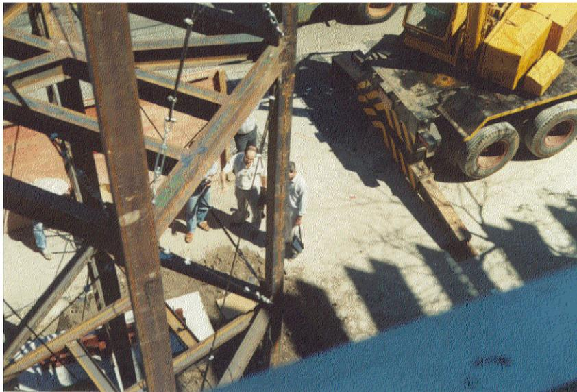
Detalhe dos esticadores e das colunas em perfil caixão, composto por dois perfis “U” soldados “de boca”.
