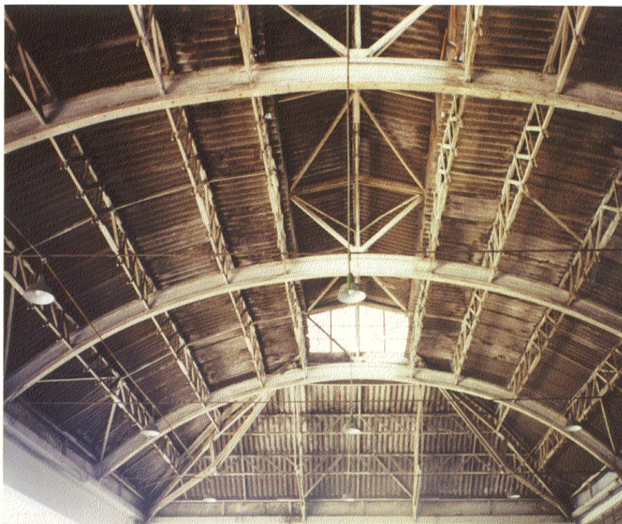
Telhado de quatro águas em estrutura de madeira em arcos bi-articulados em seção “I”, executados com tábuas arqueadas, pregadas e cavilhadas entre si, terças treliçadas, lanternim para iluminação, correntes das terças. Contraventamento feito pelos semi-arcos nas diagonais (“figura do triângulo”), correntes frechais rígidas e respectivas terças.
