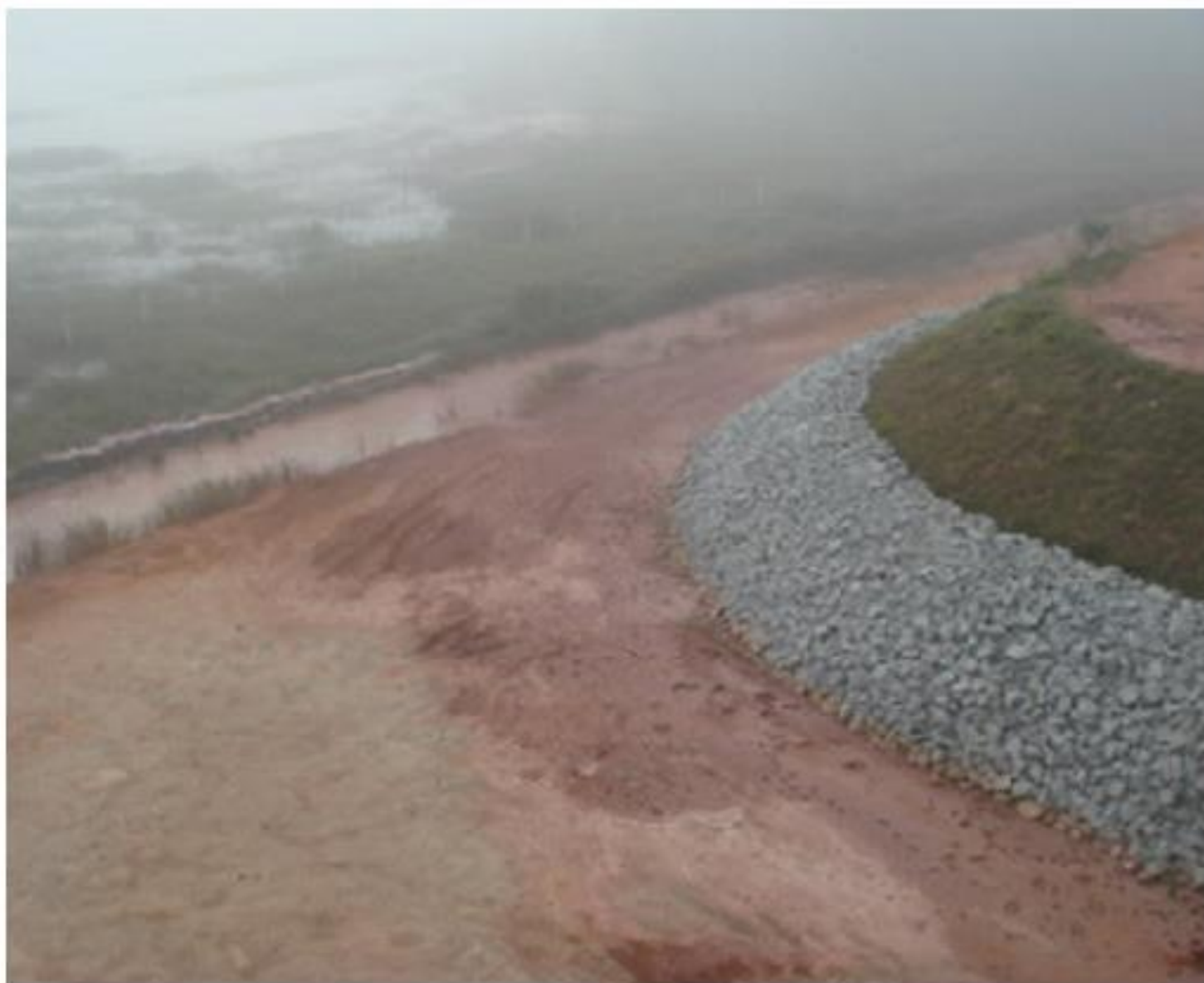
Proteção vegetal e enrocamento no pé de aterro. Drenagem provisória: canal de contenção e material
