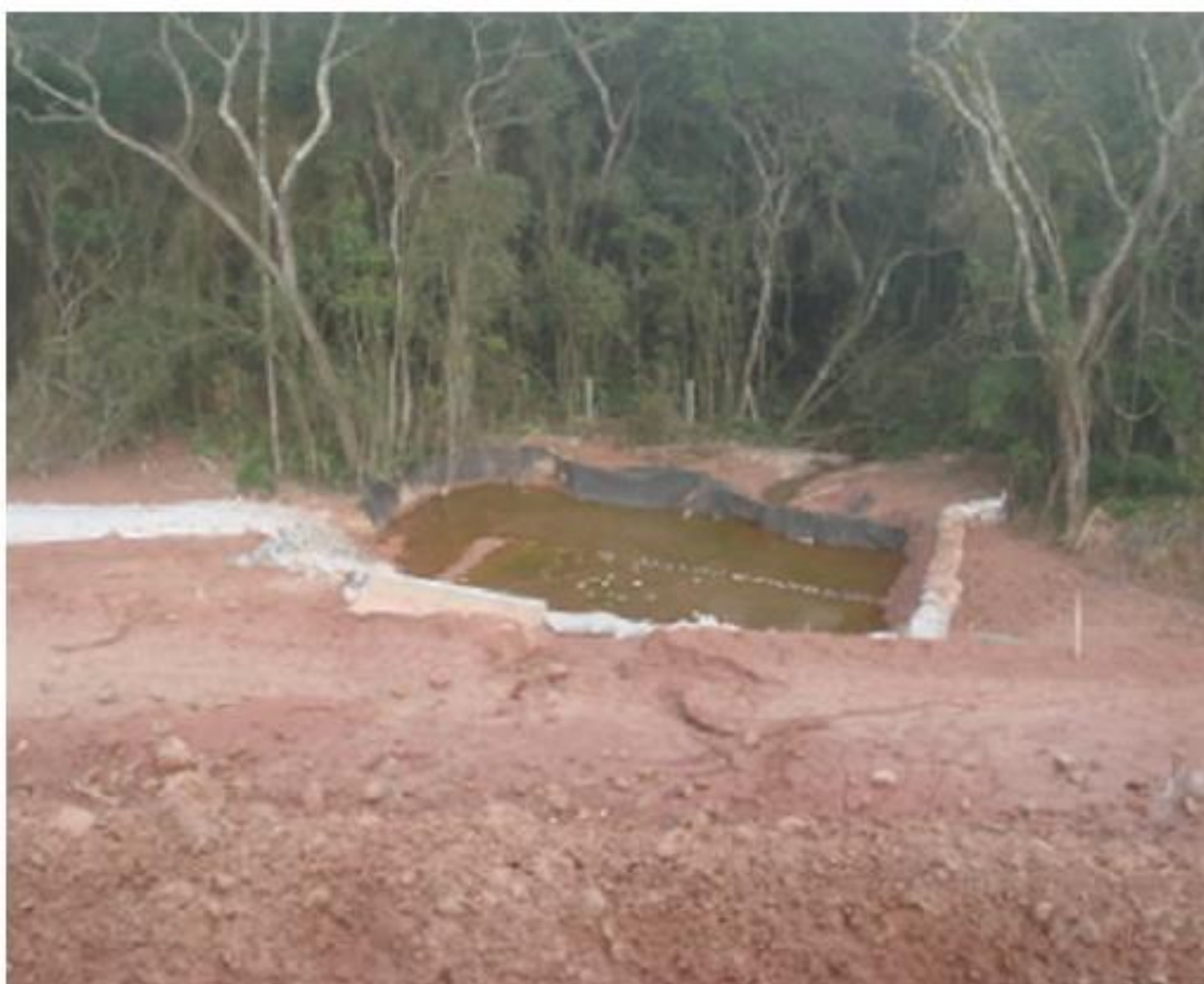
Drenagem provisória: reservatório de contenção, filtro de manta e pedras para retenção de finos suspensos
