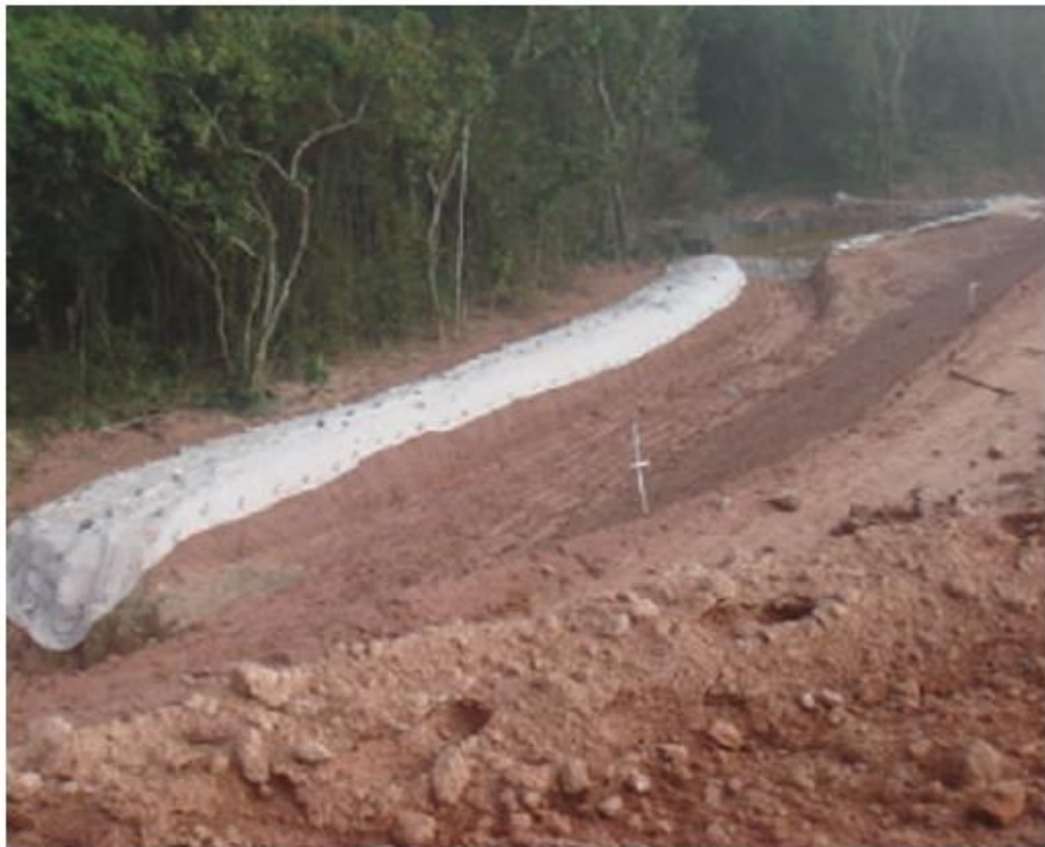
Drenagem provisória: vala de encaminhamento com a crista de jusante protegida
