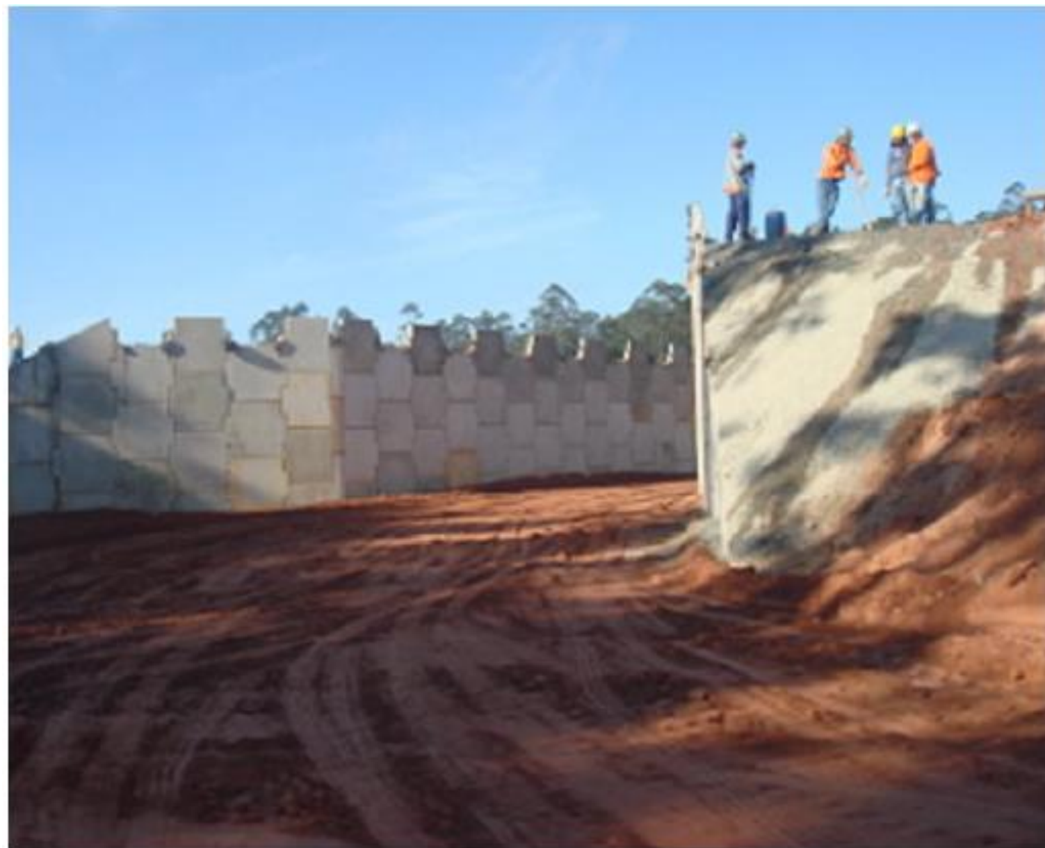
Muro de arrimo com terra armada.
