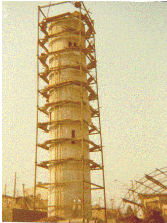
Plataformas de trabalho contraventadas na própria torre da caixa d'água. Torre de caixa d'água - Centro Social Esportivo, Guarulhos –São Paulo.
