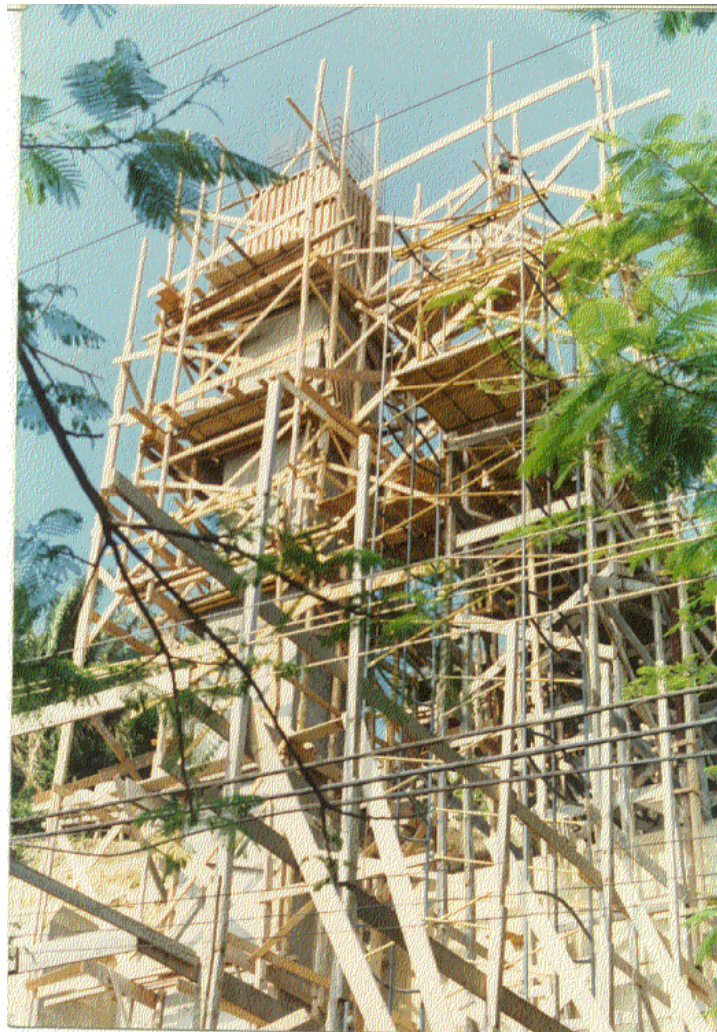
Cimbramento com pontaletes de pinho 8 x 8 cm contraventados com tabuas. Torre de elevador para acesso à casa no alto de uma pedra – Rio de Janeiro.
