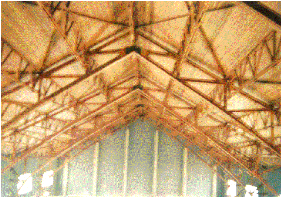
Barras tracionadas e comprimidas de sistemas treliçados. Velho galpão em pórtico treliçado – bairro da Luz, São Paulo – Capital
