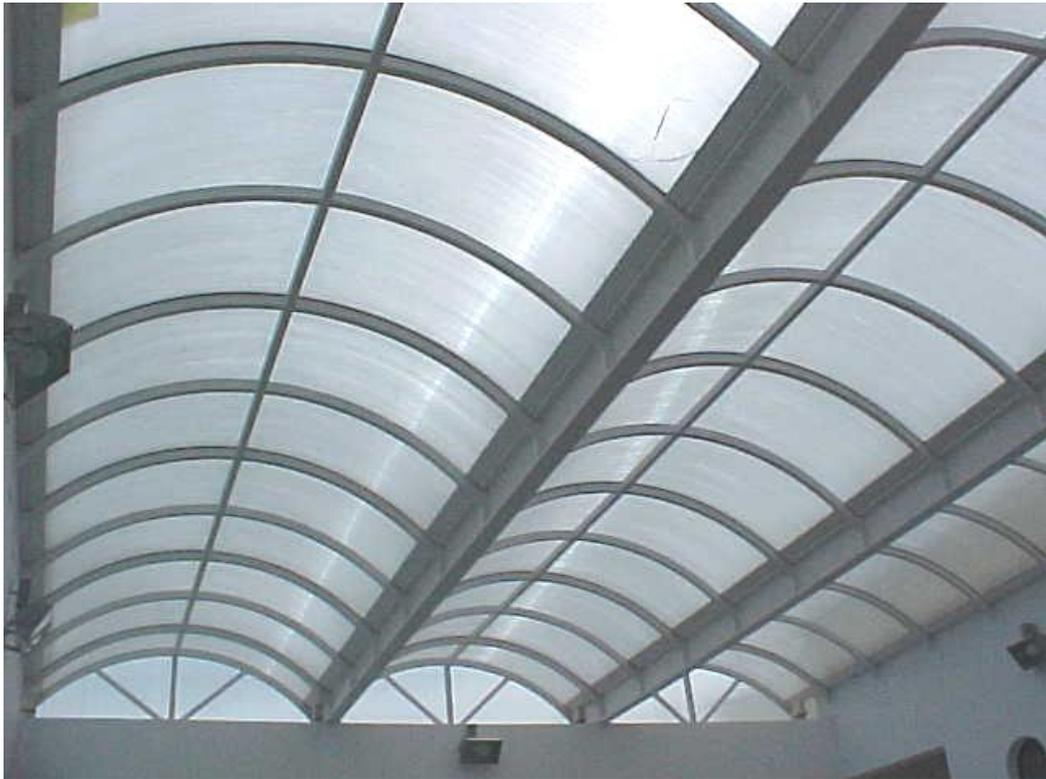
Vigas secundárias em formato de semi-arcos, funcionando como travamentos laterais contra flambagem lateral com torção ( F.L.T.) , em pontos isolados.
